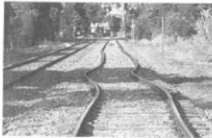
Fig. 2 . Trilhos instalados sem os devidos cálculos.
